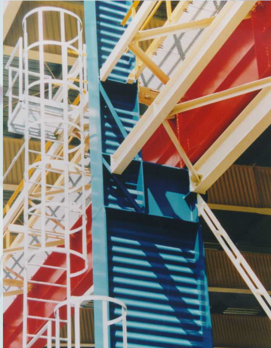
VA - Stahl, Warmbundhalle
